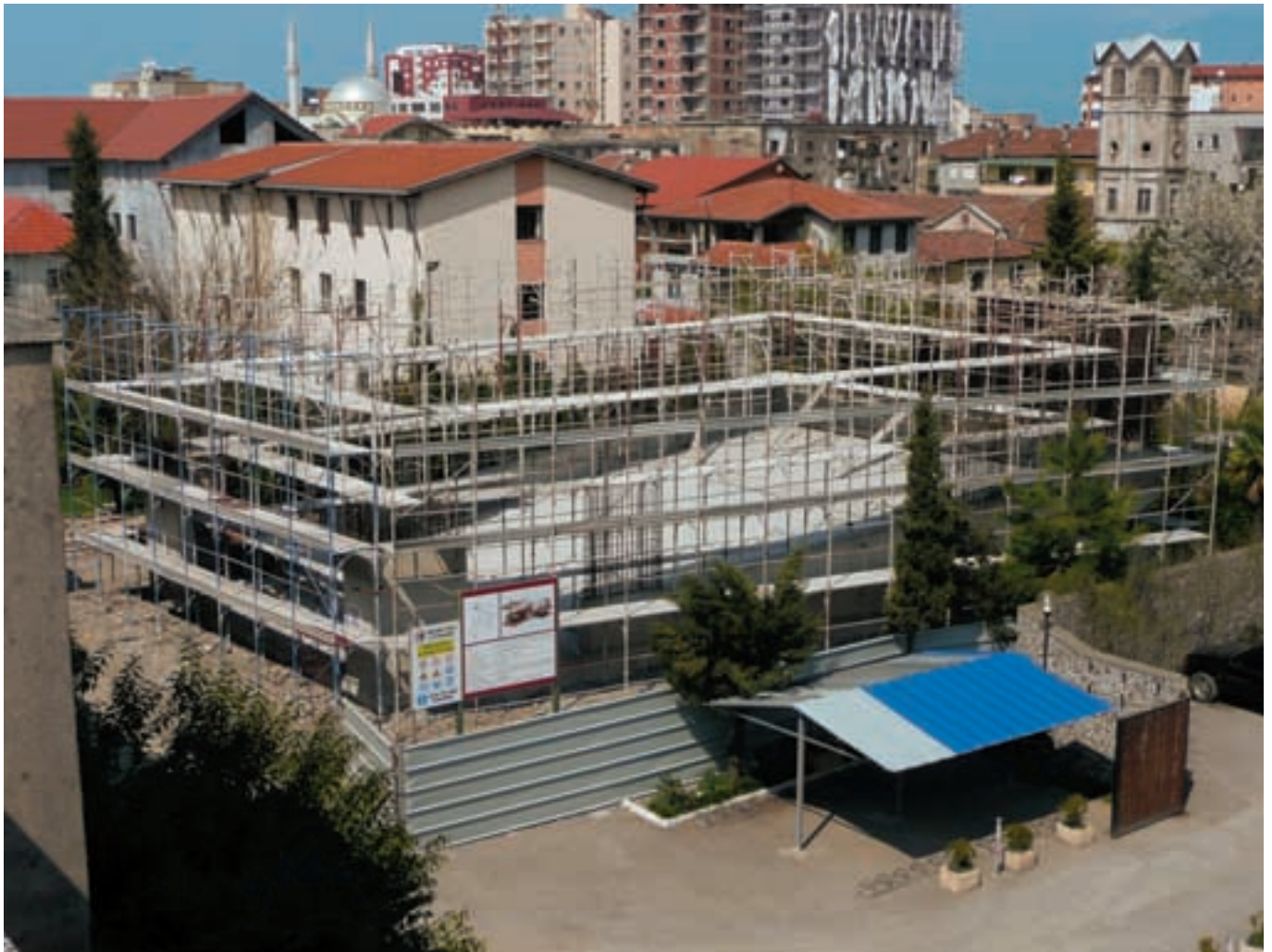
I lavori in corso per il rifacimento del liceo «Meshkalla»
