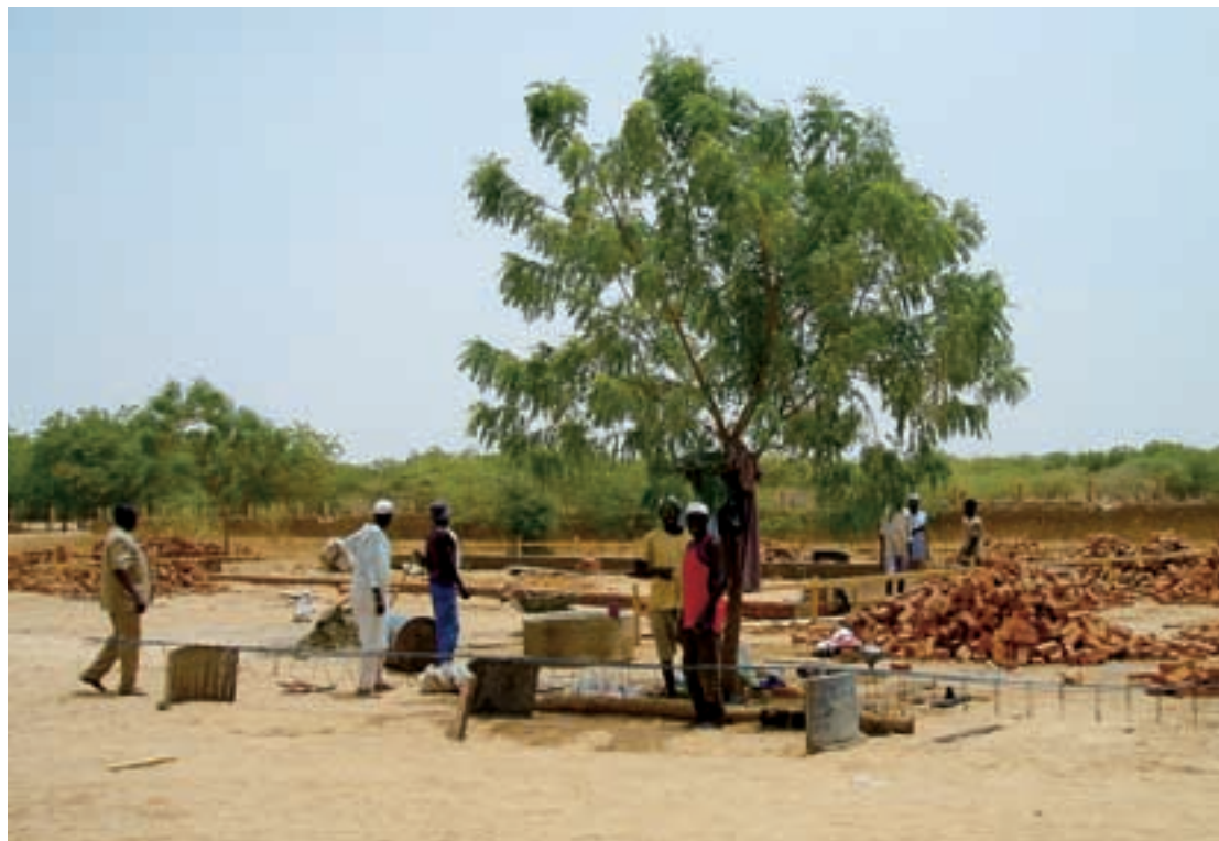
Inizio dei lavori per la costruzione di una Scuola comunitaria nel Guéra
